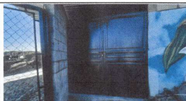
Foto 6: Sustrucción de portón de metal en bodega 1
