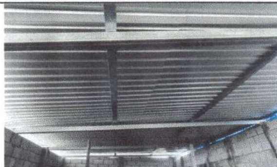
Foto 2: Sustrucción de estructura de soporte de madera, por metal. bodega 1
