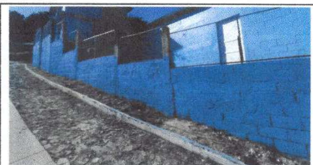
Foto 12: Reparación de muro perimetral de block con tubo hg y malla galvanizada, soleras intermedias y columnas. Entrada principal
