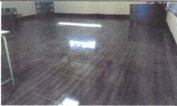
Foto 9: Sustrucción de piso cerámico en aulas de Primaria
