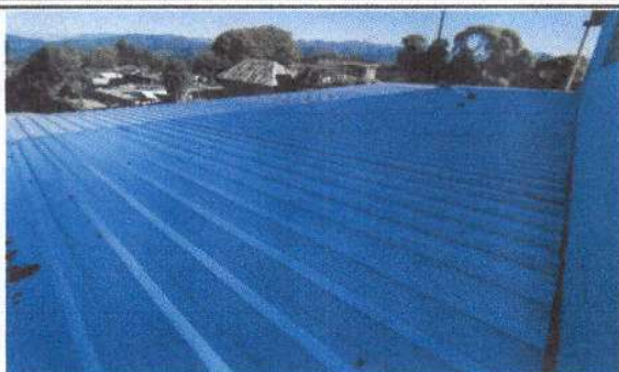
Foto1: Sustrucción de lámina por lámina troquelada aluzinc calibre 26. bodega 1
