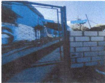
Foto15: Reparación de muro perimetral de block, entrada principal
