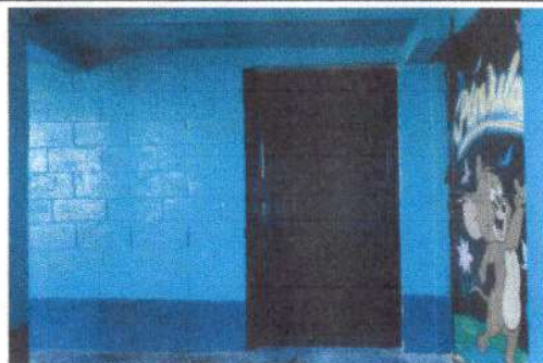
Foto 4: Sustrucción de puerta en bodega No. 2
