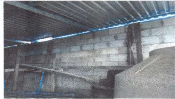
Foto 14: Reparación de muro perimetral para cubierta de lamina en bodega 1
